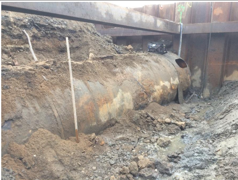
Figur 13. Cisternen i schakten innan den lyfts upp och bottenplattan frigjorts. I borte änden anas det plåtband med viket den var förankrad i betongplattan.
