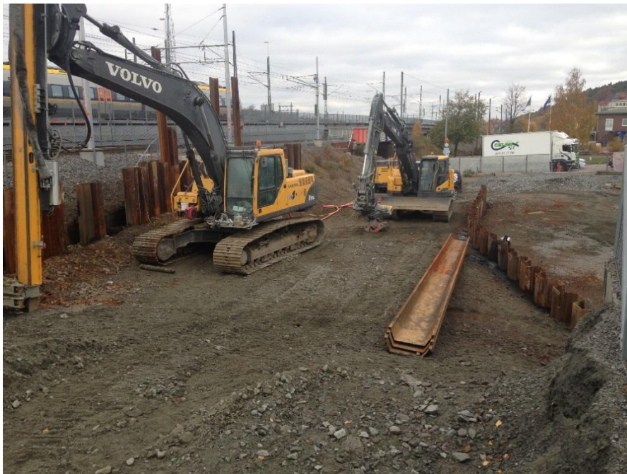
Figur 11. Förborring inför spontslagning, till höger i bild är den östra sponten.
