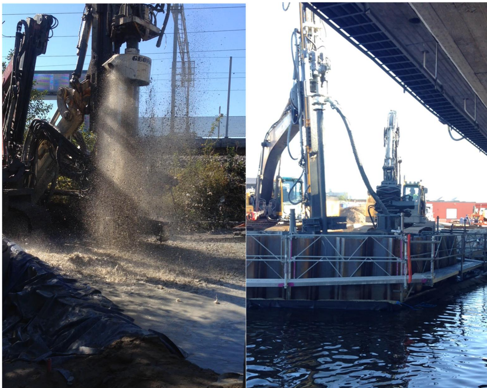
Figur 6. Till vänster en bild från provborrningen innan entreprenadstart utan slangmunstycke och till höger en bild från borrning i spontlåda för brostöd i Sävåån med slangmunstycke. Grävmaskinen intill borrhjgen är utrustad med en gripklo och håller ned slangen i en container där borrhslammet samlas upp.
