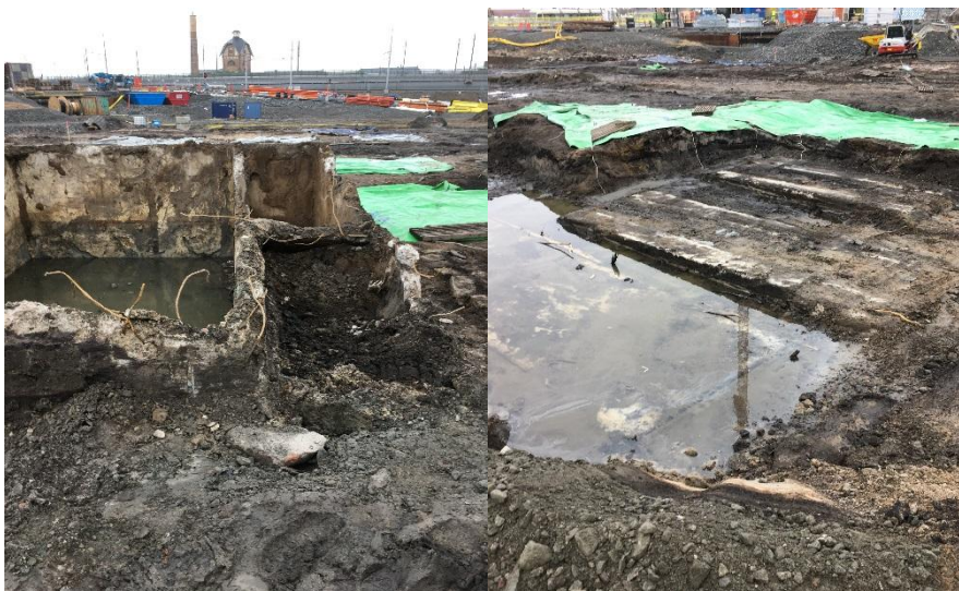
Figur 10. Till vänster grunden efter det att den tömts på avfall och till höger syns tre av de fyra bottenplattorna som påträffades.
