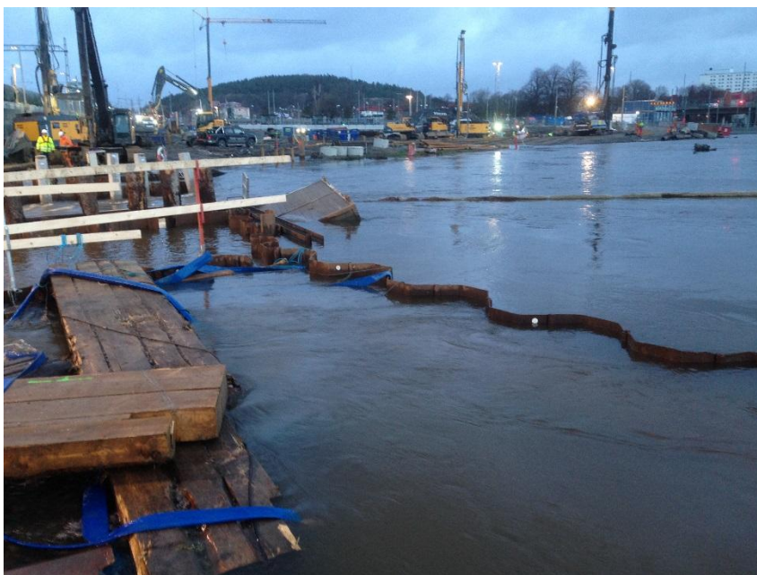
Figur 9. Vy från södra åkanten vid läge för brostödet för blivande spårvägsbro.
