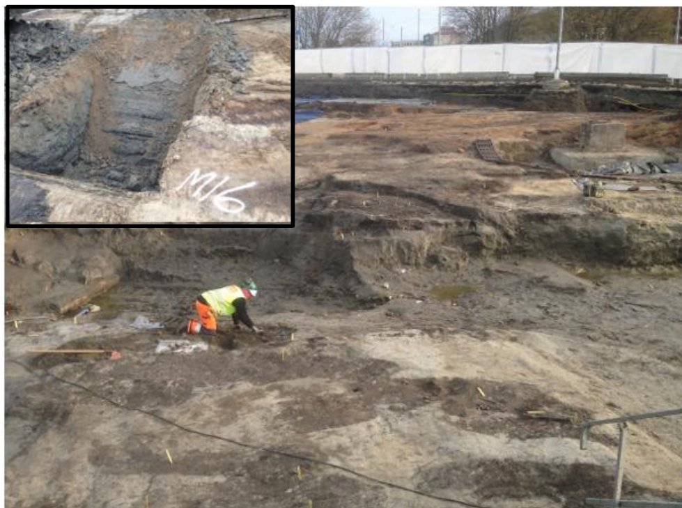
Figur 17. Schaktbotten med sand och fyllnadsmassor. Efter okulär kontroll av ytan utfördes provgropar (se figurens vänstra hörn) i syfte att säkerställa att inga andra typer av massor fanns under sanden.
