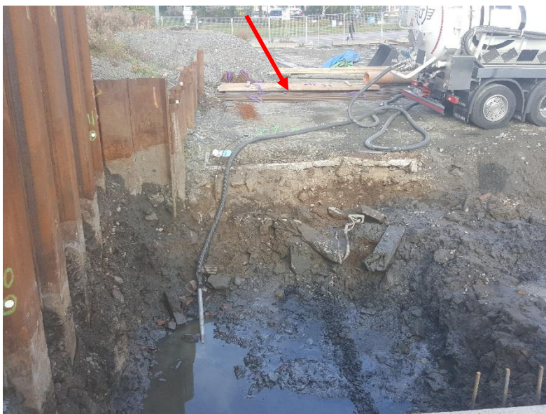
Figur 14. Omhändertagande av oljevatten efter det att cisternen lyfts upp och betongplattan knackats. I detta foto syns även området för leca-fyllningen (röd pil) där restförorening lämnats och där oljepåverkat vatten omhändertagits.
