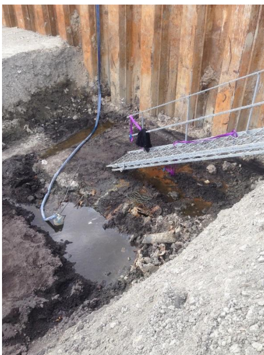
Figur 4 En av de mindre schakterna längs med sponten inom område 4:10.
