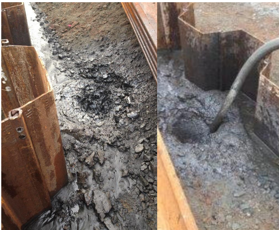
Figur 12. Till vänster: uppträngande oljevatten. Till höger: omhändertagande av oljevatten pågår samtidigt som borrhning utförs.
